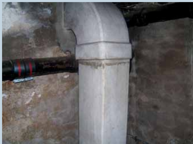
Bild 3 Luftschacht aus Asbestzement [C.2]
