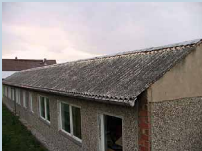
Bild 2 Dachdeckung aus Wellasbestzement [C.1]
